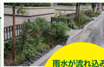
← バイオスウェル 道路脇の植栽を改良したもの
